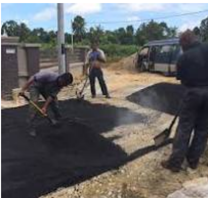
Figure Hari ini kerja-kerja menurap tar... - The Zagha Development ...
